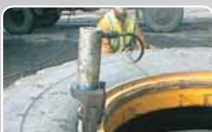
7 Separare l'anello conico dall'anello laterale
