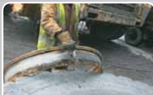
3 Lubrificare la superficie conica dell'anello conico
