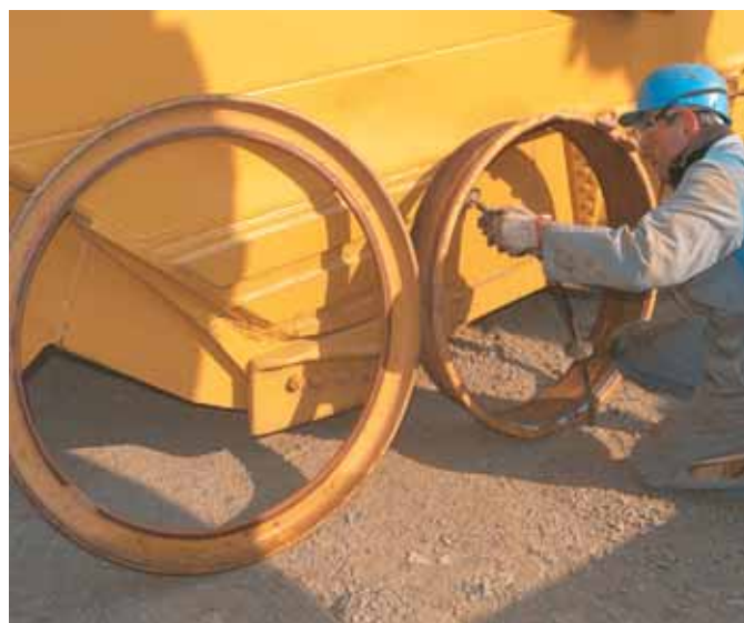
Pulire e, se necessario, ridipingere le parti arrugginite del materiale in ferro
