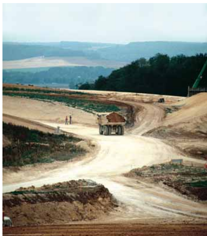
La regolarità del tracciato limita l'usura a cono
